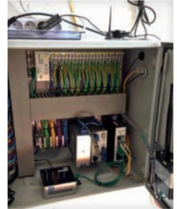
Links sind die für das Forschungsvorhaben provisorisch eingebauten Messwandler an den Abgängen der Niederspannungshauptverteilung einer Ortsnetzstation zu sehen. Das Bild rechts zeigt die Messwertverarbeitungstechnik und Kommunikationsanbindung der Ortsnetzstation.
