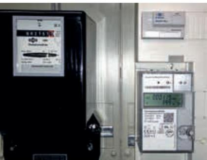
Hier im Vergleich: Links der gewohnte Ferraris-Zähler und rechts das Messsystem der Zukunft. Dies zeigt dem Kunden neben dem Zählerstand in Kilowattstunden auch die aktuelle Leistung
